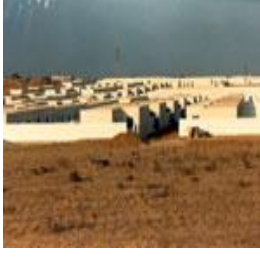
مجمع سكني من 3000 منزل مصبوبة موقعيا باستخدام NEOPOR® CLC في تونس
